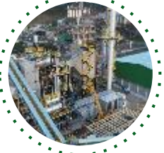
Ingredion Balsa Nova
