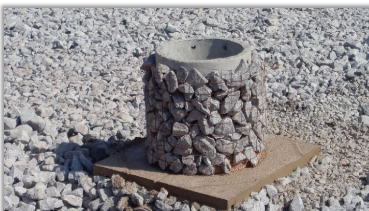
Sistema de drenagem de chorume e gases interna
