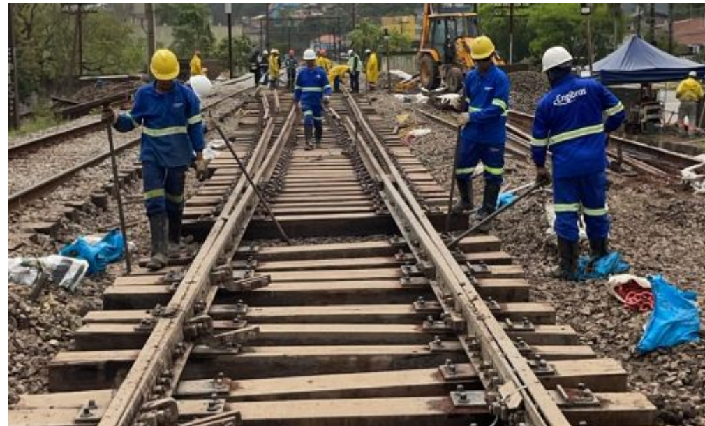
Manutenção Linha 10 CPTM
